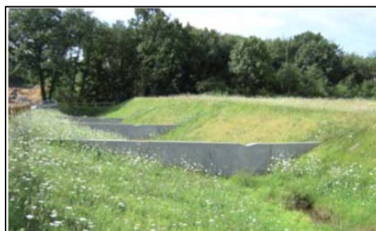
Figure 17 : Exemple de noue de rétention
